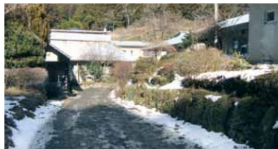
「かりいほ」の居住棟
